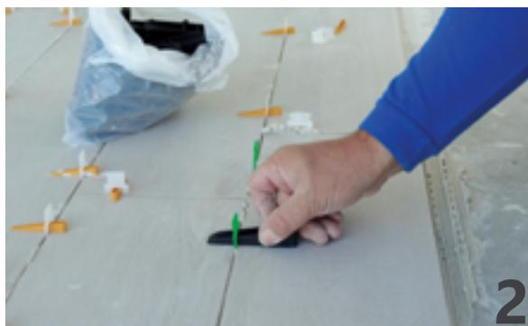
Colocar correctamente el nivelante tras la baldosa, y una vez colocada la adyacente introducir la cuña.
