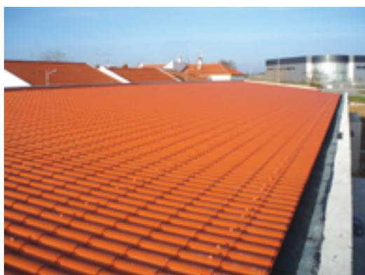
SI ES NECESARIO, LA ÚLTIMA PLACA DEBERÁ ADAPTARSE A LA ANCHURA AJUSTÁNDOLA CON UN DISCO ABRASIVO. EN ESTE PUNTO ES NECESARIO COMPLETAR LAS FIJACIONES SEGÚN EL ESQUEMA DE LA FIGURA.
