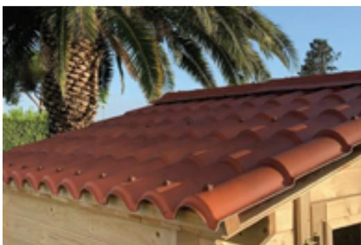
SUPERPONER LATERALMENTE LA SEGUNDA PLACA SOBRE LA PRIMERA Y FIJARLA EN LA PARTE INFERIOR, EN CORRESPONDENCIA CON EL SOLAPAMIENTO.
