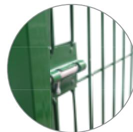
Puertas metálicas peatonales elaboradas de varilla de acero galvanizado, posteriormente recubiertas con una nueva tecnología de nano-galvanizado.
