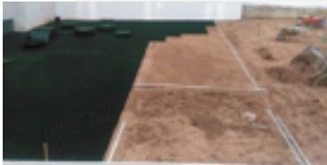
4. Coloque las rejillas de malla correctamente asentadas.
