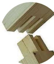
Estructura de madera que se compone por dos largueros y un cabezal que se usa para fijar la puerta al muro en el que se instale usando tornillos, grapas o algún otro sistema de fijación. Los premarcos de madera se colocan al mismo tiempo que los tabiques, y permiten que podamos cambiar las puertas con solo desmontarlas del premarco, evitando que tengamos que romper el tabique.
