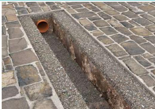
1. Calcule los tamaños de las zanjas teniendo en cuenta las medidas de los elementos (ancho x alto) y espesor del lecho de hormigón sobre el que se colocará la canaleta.
