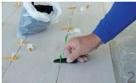
Colocar correctamente el nivelante tras la baldosa, y una vez colocada otra baldosa, introducir la cuña.
