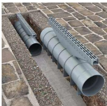
3. Coloque el conjunto en la base y conéctelo a la tubería de drenaje.
