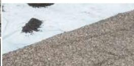
2. Extender una pantalla de "geotextil" sobre la parte superior.
