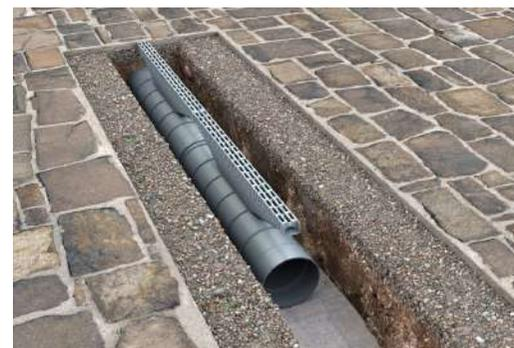
4. Si la línea de drenaje requiere más de un elemento, conéctelos mediante enclavamiento macho-hembra y asegúrese de que estén alineados.
