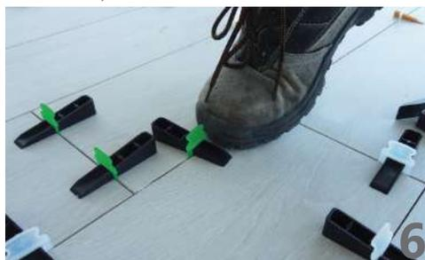
Transcurridas 24 horas, tiempo necesario para el secado del mortero, retirar las cuñas con un golpe seco en dirección de la junta, bien con una maza de goma, con el pie o con la misma tenaza. La base quedará debajo de la baldosa, pero la cuña quedará libre y listo para un nuevo uso.
