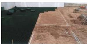
4. Coloque las rejillas correctamente asentadas.
