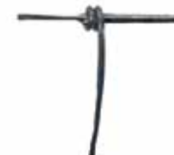
Detalle nudo final de malla
